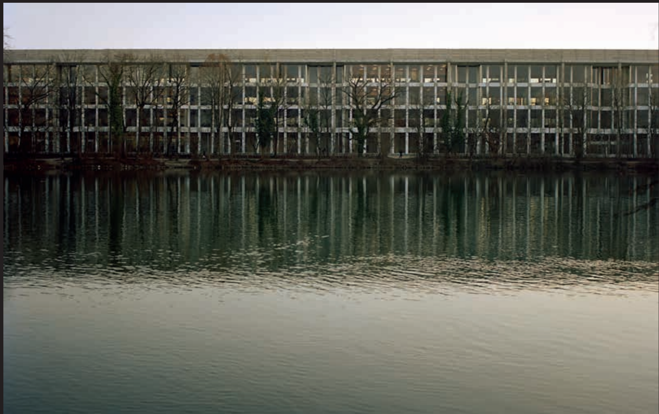
Studio Märkli, Synthes Headquarters, Zuchwil, 2012. View of the building from the opposite bank of the Aare river. | Vista dell'edificio dalla sponda opposta del fiume Aare. Ph. Caroline Palla, 2012.
