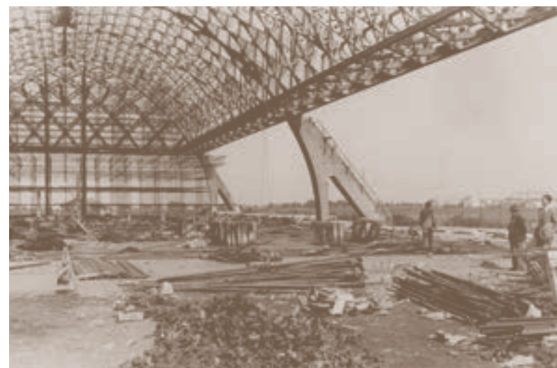
Pier Luigi Nervi, Aviorimessa dell'idroscalo di Orbetello | Orbetello seaplane base, Grosseto, 1942. Cantiere | Construction site. MAXXI Museo nazionale delle arti del XXI secolo, Roma. Collezione MAXXI Architettura. Pierluigi Nervi F4224.
