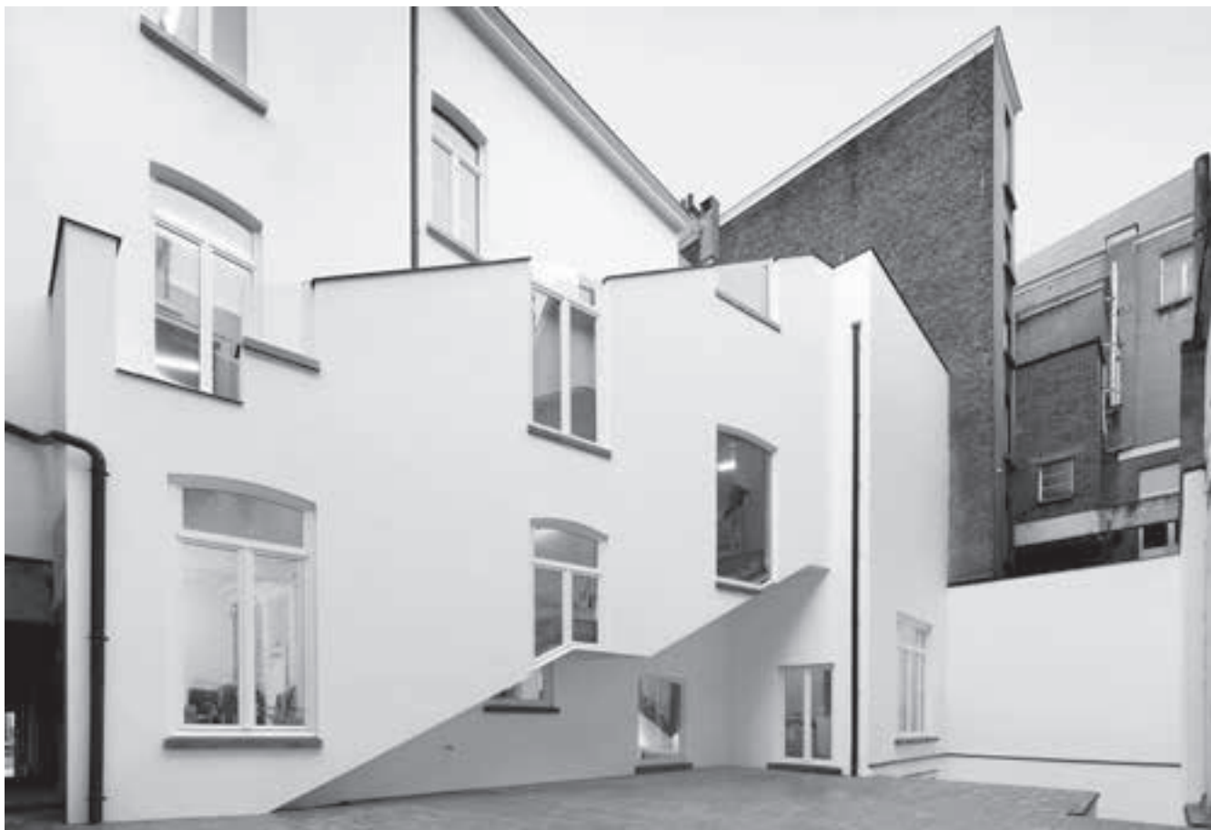
Architecten De Vylder Vinck Taillieu, Twiggy, Gent, 2012. Fronte verso il cortile con l'inserimento della nuova scala. | Façade towards the courtyard with the insertion of the new staircase. Ph. Philip Dujardin, 2012.
