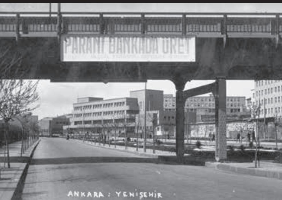
Ankara. View north from Ataturk Avenue with the Sıhniye Railway Bridge in the foreground. In the background is the İsmet İnönü Girls' Institute (arch. Ernst Egli, 1930). | Ankara. Veduta di viale Atatürk verso nord con il ponte ferroviario di Sıhniye in primo piano. Sullo sfondo è l'Istituto femminile İsmet İnönü (arch. Ernst Egli, 1930). Illustrated postcard | Cartolina illustrata, 1930. Source | Fonte archivio Koç University – VEKAM Archive.
